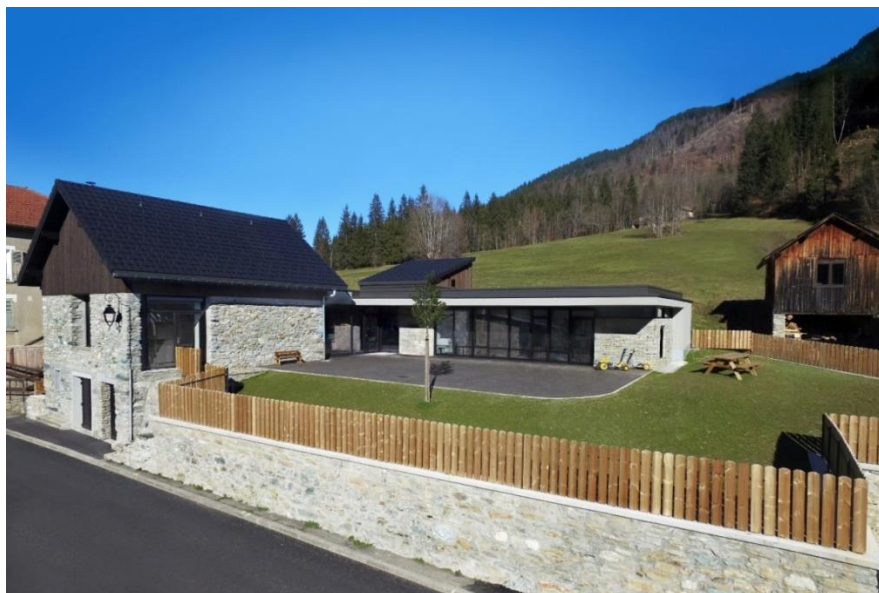
Figure 1 : Construction de la nouvelle école primaire et réhabilitation d'une grange patrimoniale - Pixel Vidéo, Sandrine Rivière
